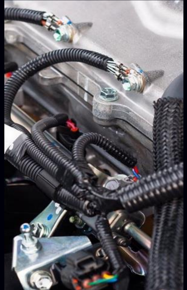
OEM: Kabelstecken in der Vormontage
